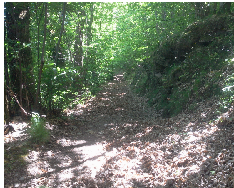
Le chantier avant les travaux
